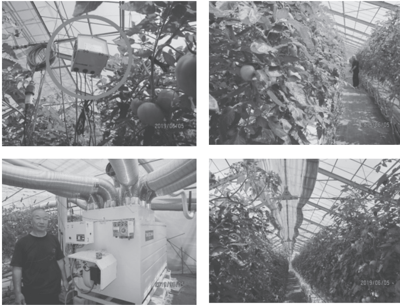
写真2 ハウス内の環境測定装置と炭酸ガス発生装置：筆者撮影
