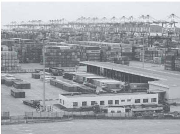
社が、共同で運営を開始した洋山港第4期ターミナルは、全長2,350mの7つのバース（7万トン級2、5万トン級5）を保有し、2.2万㎡の面積を持つ、世界最大の完全無人自動化コンテナターミナルである。現在は、年間取扱量4百万TEU規模のターミナルを運営しているが、2020年の完成時には処理能力6.3百万TEUを計画している。
