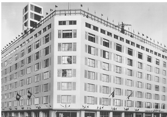
写真3 博多帝国ホテルが入っていた東邦生命福岡ビルディング
