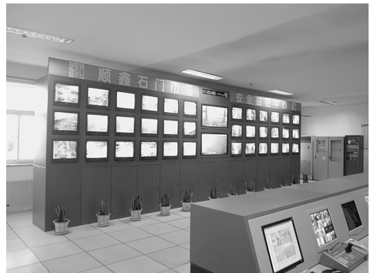
写真3 石門市場のセキュリティ監視センター 出所：筆者撮影。
