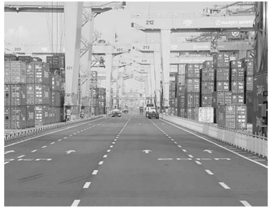
写真10：水平構造自動化システムで運営されているヤード内
