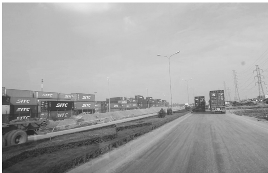
写真8：拡張工事が進むハイフォン港のコンテナヤード
