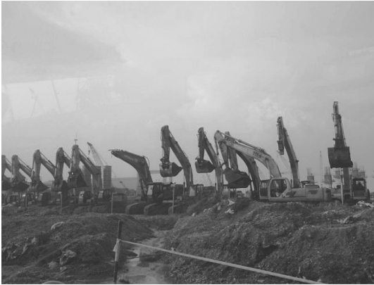
写真16：ハイフォン港建設現場の様子
