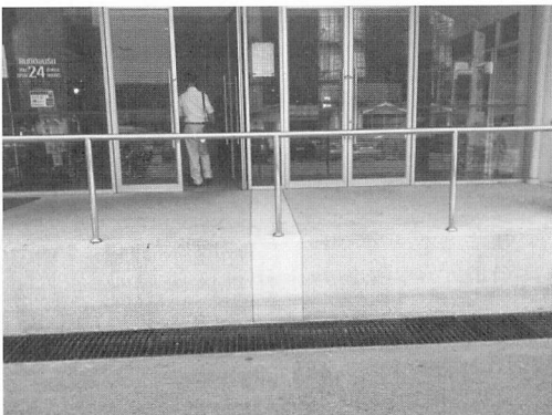
写真1 イオングループの店舗も床下浸水
