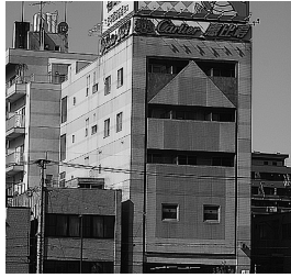
図14. ビル、長方形の側面に二等辺三角形が折り込まれている
